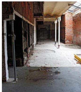
Die denkmalgeschützte ehemalige Fischräucherei wird kernsaniert. Nach dem unvorhergesehenen Auszug der Druckerei sind neue Nutzungskonzepte gefragt.
