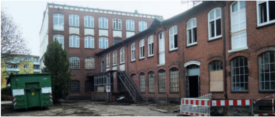
Das Gebäude der Druckerei St. Pauli wird derzeit kernsaniert.
